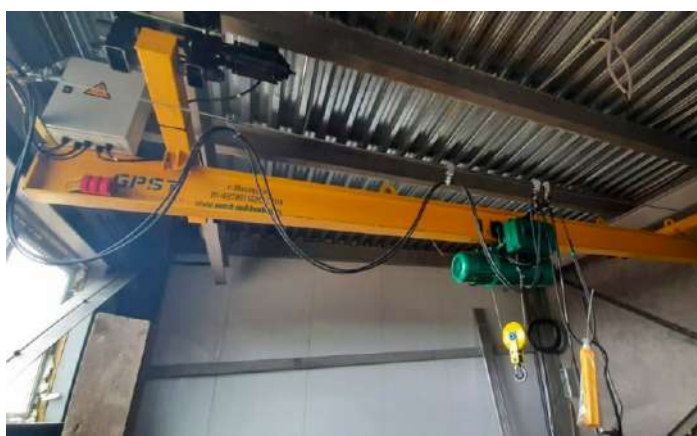
Кран мостовой подвесной г/п 1,2т, высота подъема 6,0м, длина пролета 10,0м, для ООО «Полимерстройпроект».
