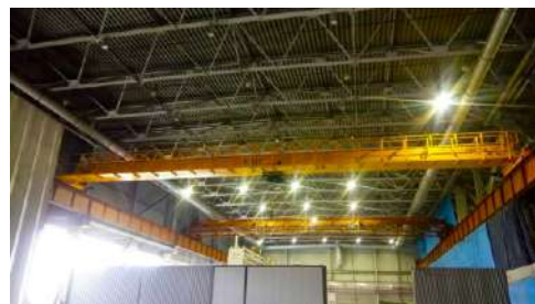
Кран мостовой опорный г/п 5,0 т, высота подъема 10,0м, длина пролета крана 22,5 м для ПАО «Корпорация «Иркут» г.Иркутск.
