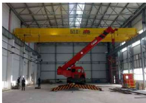
Кран мостовой опорный двухбалочный г/п 50,0т высота подъема 12,0 м, длина пролета 22,5 м с кабиной, для АО «Дальневосточный завод Звезда» г. Большой Камень
