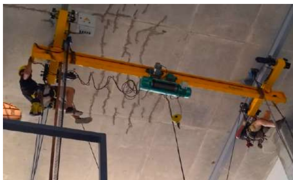
Кран мостовой подвесной г/п 1,0т, высота подъема 6,0м, длина пролета 4,5м, для ООО «Русагро-Приморье»
